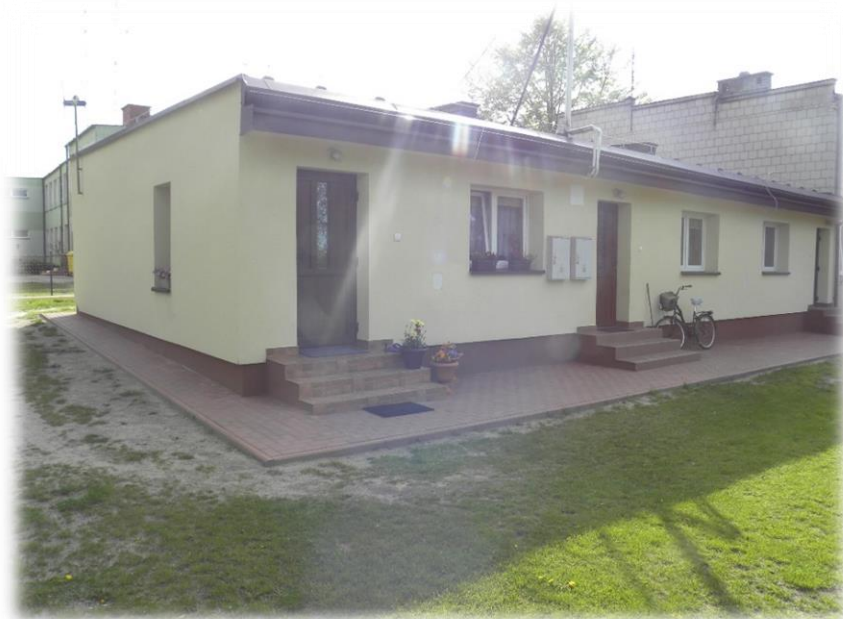
Zdjęcie przedstawia nową elewację budynku, chodnik z kostki i pokrycie schodów z terakoty
