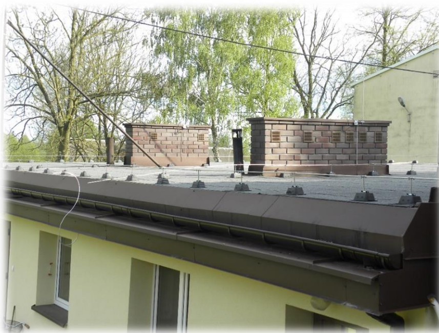
Nowe czapki kominowe i pokrycie dachu z papy
