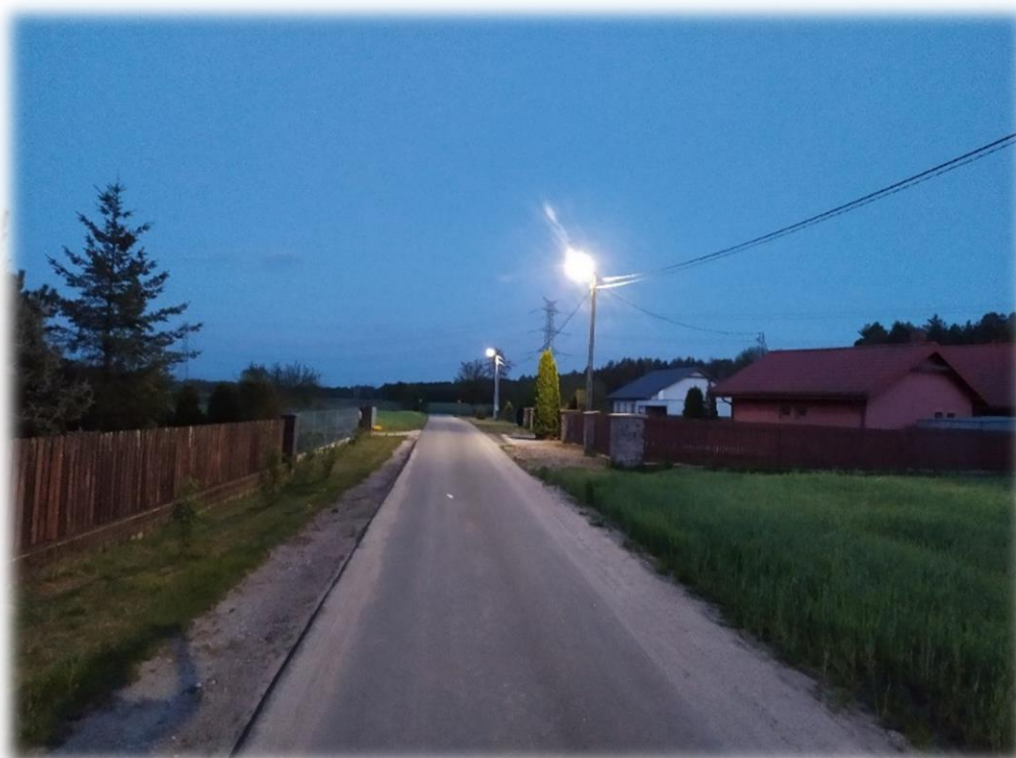
Zdjęcie oświetlenia ulicznego drogi od strony leśniczówki w części miejscowości Domanice (tzw. „Gajówka”)
