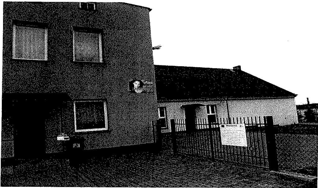
Sala Wiejskiego Domu Kultury w Domanicach
