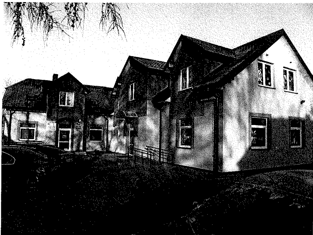
Budynek przedszkola i biblioteki w Domanicach
